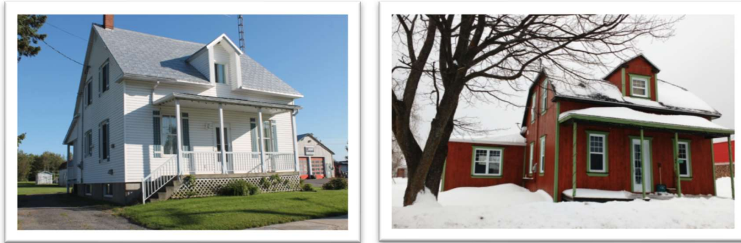
Figures 28 et 29: 2 autres modèles de toit à 2 versants droits. Le premier, à gauche, possède une lucarne pendante à 2 versants droits et la seconde une lucarne aussi à 2 versants droits. Les 2 possèdent un étage et demi et ont toujours leurs retours de corniche. Maisons sises dans le noyau patrimonial du Secteur Précieux-Sang, Ville de Bécancour. Crédit photo: Patrimoine Bécancour.
