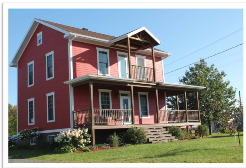
Figure 30: Demeure à 2 versants droits de deux étages et demi avec ses retours de corniches. Un balcon couvert repose sur le toit de la galerie couverte courante au premier niveau. Maison sise dans le noyau patrimonial du Secteur Précieux-Sang de Ville de Bécancour. Crédit photo: Patrimoine Bécancour.
