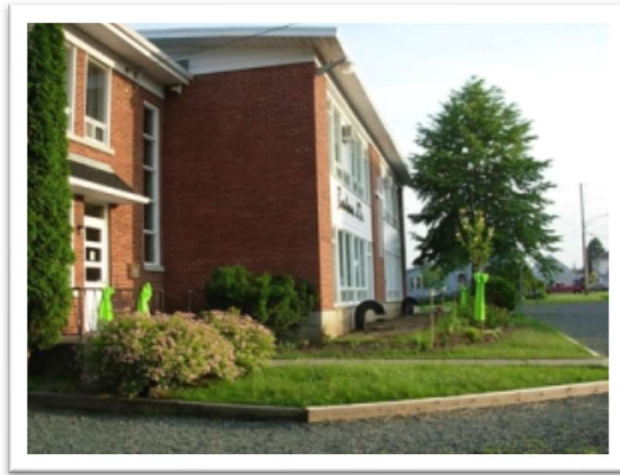
Figure 25: École primaire les Boutons-d'Or fait partie du bâti spécialisé du domaine scolaire. Elle se situe au 11005, Chemin du Saint-Laurent, Secteur Précieux-Sang (Ville de Bécancour).
