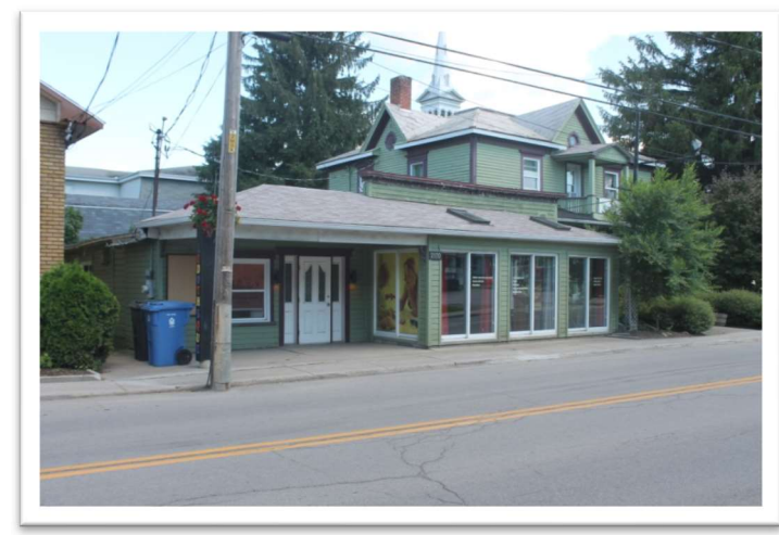
Figure 6: Illustration d'un bâtiment mixte au 2160-2170, boulevard Bécancour, sis dans le noyau du Secteur de Gentilly, ayant 2 locaux non résidentiels. Crédit photo: Patrimoine Bécancour.
